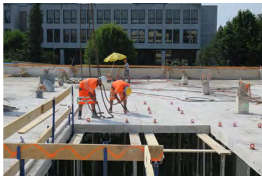
Fig. 13 : Photo du levage d'un élément de dalle, projet Rebuilt © Rebuilt_DSC
