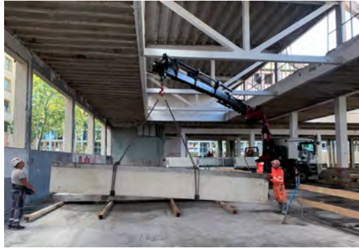
Fig. 5 : Photo du levage d'un sommier, projet C © Commune de Meyrin, ATBA, Atelier d'Ici, ZS, Sotrag SA, Construction Perret SA, Labotech
