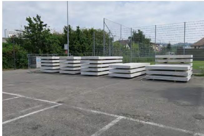
Fig. 16 : Photo du stockage des éléments de dalle, projet Rebuilt © Julien Pathé_2401-Mur de soutènement Renens
