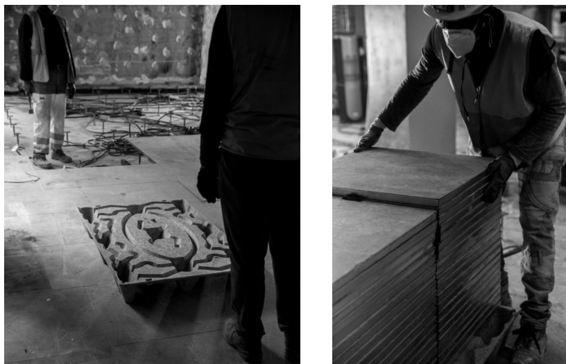
Fig. 3 : Dépose met conditionnement de FP sur palette aggloméré ©Mobius
