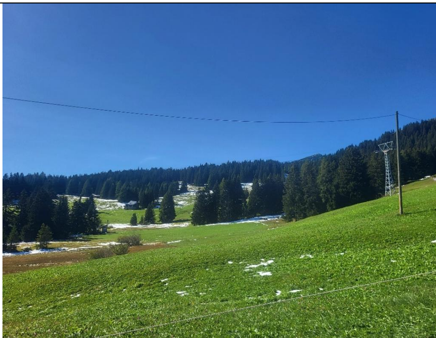
Figure 2. Dans le périmètre hydrologique de l'objet-marais « Heidsee, Pedra Grossa », il existe des infrastructures de transport et de loisirs.
