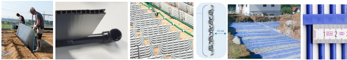
Abbildung 10: Ausführungsformen von Flächenkollektoren und Kapillarrohrmatten: Der MultiQ Geo (links) ist ein langer Kunststoffkollektor, der in Gräben installiert wird, der GeoCollect (Mitte) besteht aus einem kürzeren Kollektor, von denen bis zu 10 in Reihe verschaltet werden, Kapillarrohrmatten bestehen aus eng angeordneten, dünnen Rohren, die typischerweise horizontal installiert werden (rechts).
