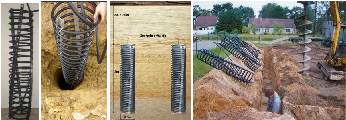
Abbildung 5: Spiralkollektoren und Einbau (Quelle: LTM)
