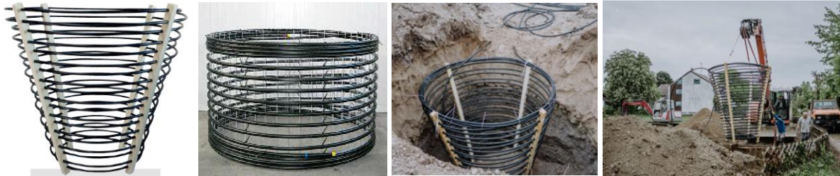
Abbildung 6: Erdwärmekörbe (links Quelle: Betatherm, Zerob) und Installation (Quelle: Betatherm)
