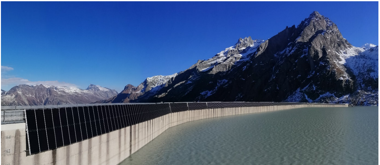
PVA-Anlage an der Albigna Staumauer (Quelle: ©REECH AG, 2020)
