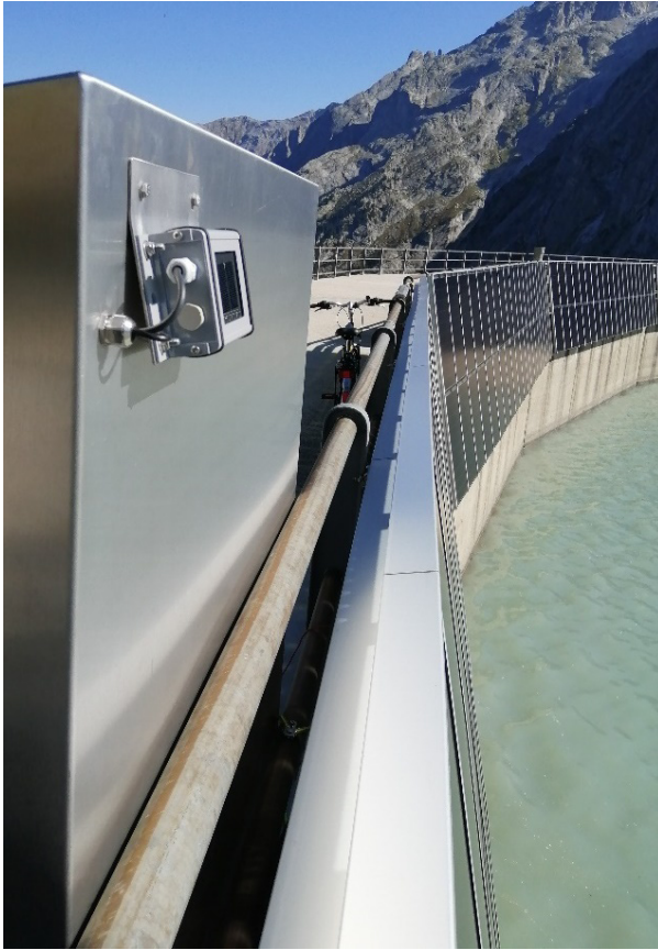
Abbildung 4 Einstrahlungssensor an GAK 1 (links); Modultemperaturfühler an Modulrückseite oberes Modul Nähe GAK 1 (rechts)
