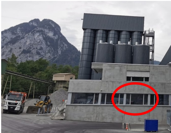
Abbildung 4 Aussenansicht der Anlage und der Standort der Überwachungszentrale.
