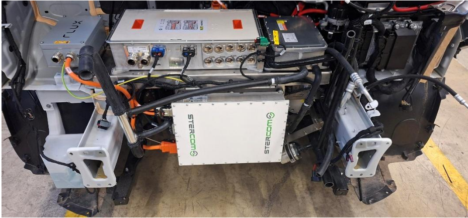
Abbildung 11 Geräteträger Flux 2.0 im Fahrzeug montiert
