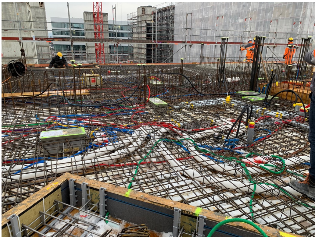
Abbildung 14: Verlegung von Bewehrung und Haustechnikrohren, Fotografie BDE Architekten
