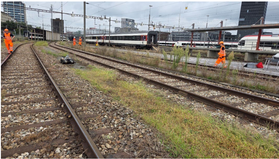
Abb. 2: Abschliessende Feldtest und Videodokumentation im Gleisbereich Basel SBB
