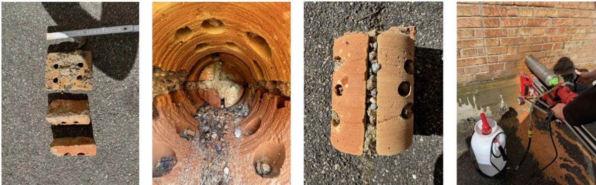
Abbildung 12: Bohrkern, Bohrloch, Kernbohrung an Mauerwerksfassade, Allschwil 2024. Fotos: Dr. Deuring + Oehninger AG
