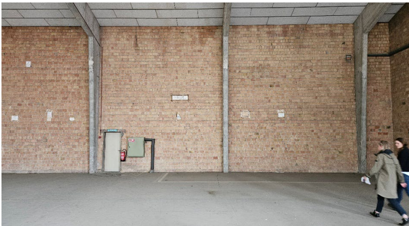
Abbildung 3: Stahlbetonskelettbau mit Backsteinausfachungen, Halle 5 Ziegelei Ost, Allschwil. Foto: FHNW
