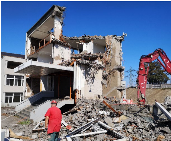
Abbildung 5: Konventioneller Abbruch, Beispiel Polyfeld MuttENZ. Foto: FHNW
