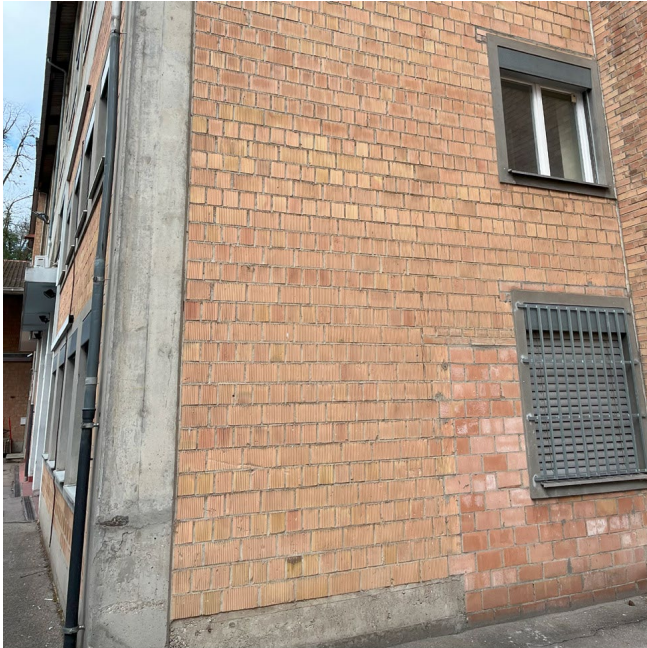
Abbildung 16: Ziegelei Ost Allschwil Aussenansicht Halle 33. Foto: Zirkular AG
