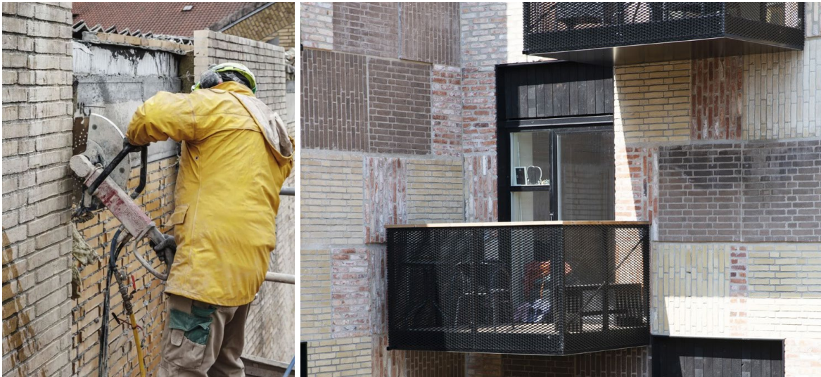
Abbildung 7: Links – Schneiden der Backsteinmodule (Foto: Rasmus Hjortshøj). Rechts - Fassade mit geschnittenen Backsteinmodulen, Wohnbauprojekt «Resource Rows» Lendager Group Kopenhagen [21].
