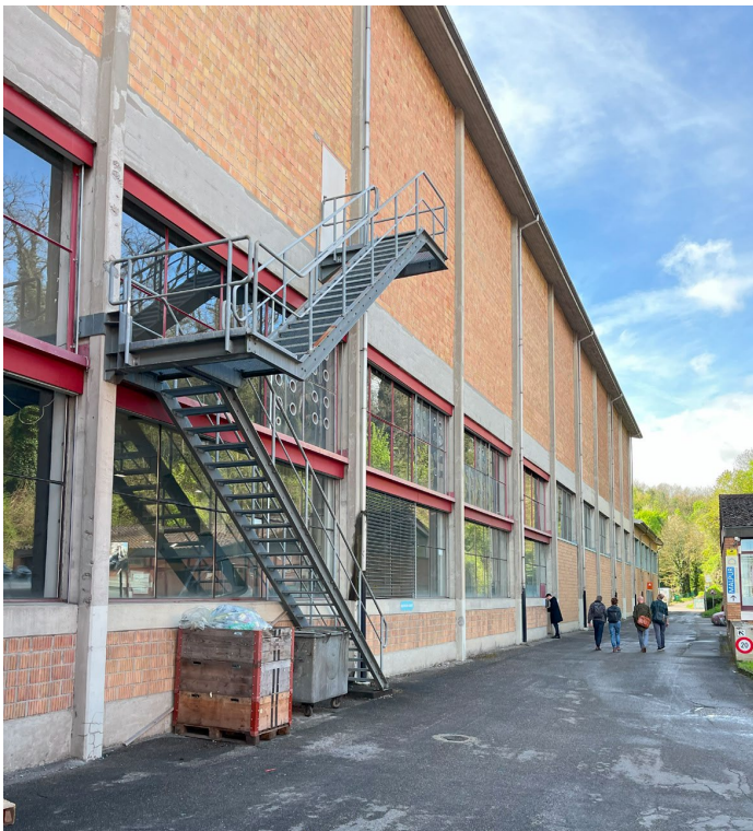
Abbildung 15: Ziegelei Ost Allschwil Aussenansicht Halle 5. Foto: Zirkular AG
