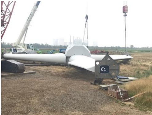
Abbildung 12: Vormontage des Rotorsterns (Nabe mit den 3 Rotorarmen)
