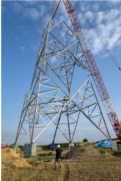
Abbildung 10: Sektionsweises Aufrichten des Turmes
