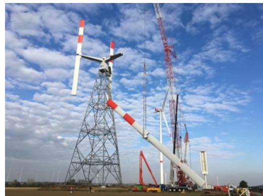
Abbildung 15: Aufrichten des 3. Blattstrangs
