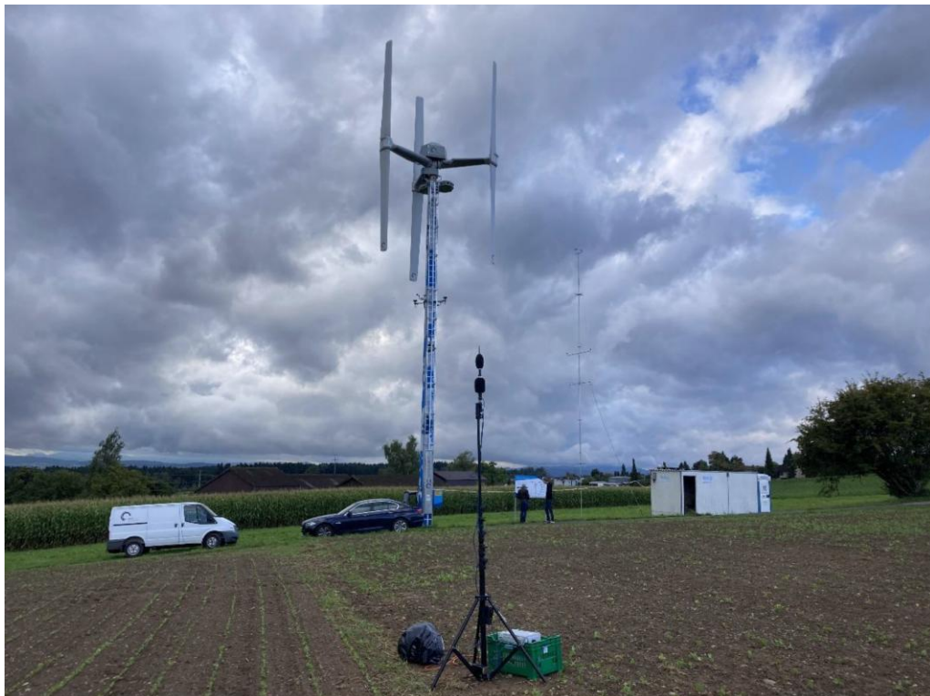
Abbildung 68: Aufstellung des Mikrofons für die Schallmessungen bei der vertikalen Windkraftanlage A6 in Brütten.
