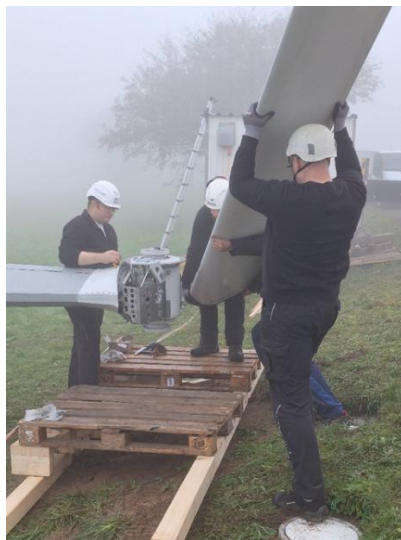
Abbildung 60: Montage obere Blätter auf Baustelle
