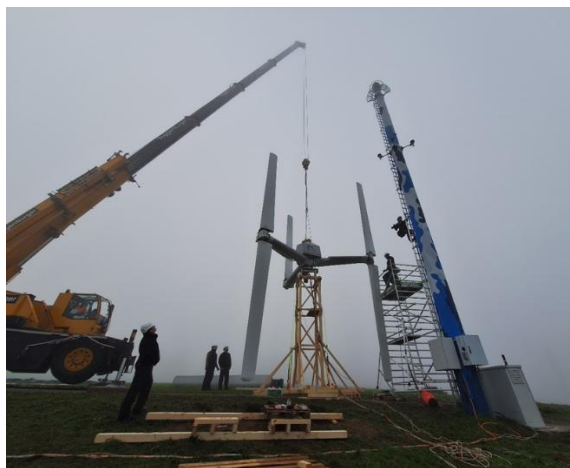
Abbildung 62: Montage untere Blätter auf Hilfsturm
