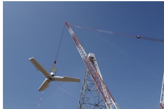
Abbildung 13: Montage des Rotorsterns mit Raupenkran
