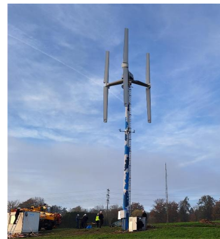
Abbildung 63: Fertig montierte Anlage A6
