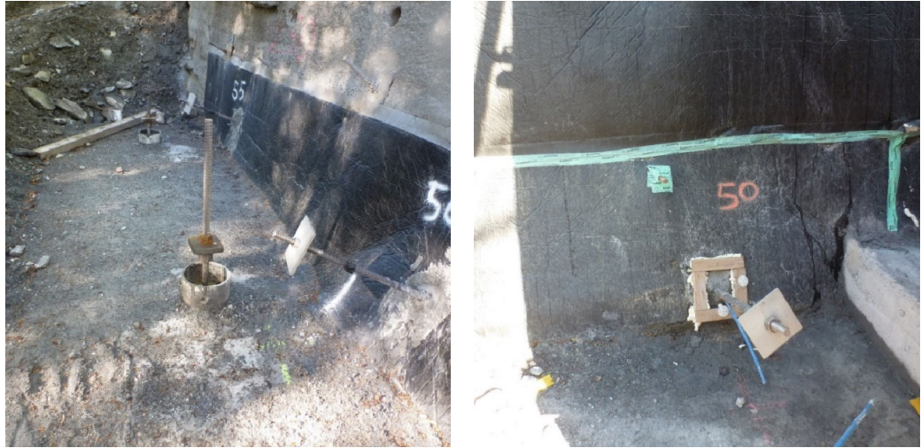
Abb. 63 Hilfskonstruktionen zur Gewährleistung mängelfreier Übergänge der Mikropfähle mit Schutzstufe 1 in den Untergrund. Links: Schutzrohr aus Kunststoff für einen sauberen Übergang zwischen Ausseninjektion und Konstruktionsbeton. Rechts: Hilfskonstruktion zur Vermeidung von Injektionsauffüllungen zwischen Entwässerungsfolie und Spritzbetonwand (Fotos René Krättli, Tiefbauamt Graubünden).
