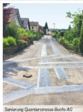
Sanierung Quartierstrasse Buchs AG
