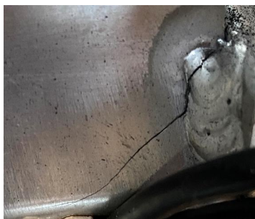
Figure 8-26 Fissure latérale 36 heures
