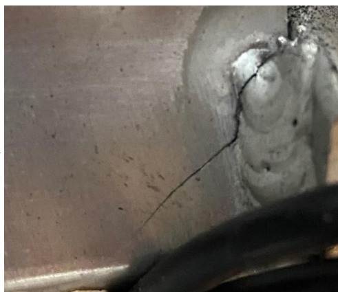
Figure 8-24 Fissure latérale 28 heures
