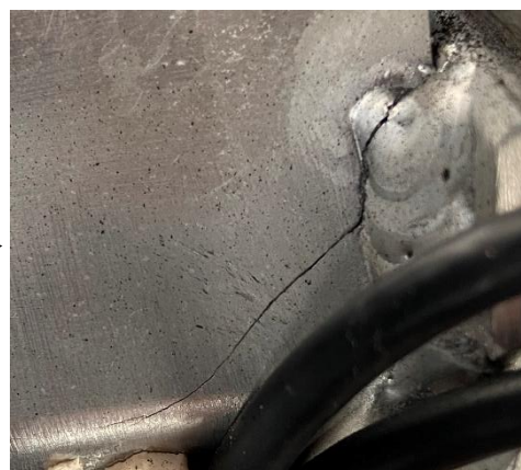
Figure 8-25 Fissure latérale 40 heures
