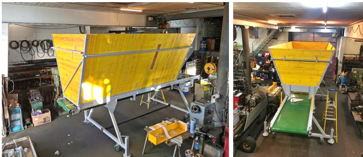
Figure 3 : Atelier d'Afcor, vue de la fabrication de la trémie de chargement combinée avec les mesures d'humidité et de masse.
