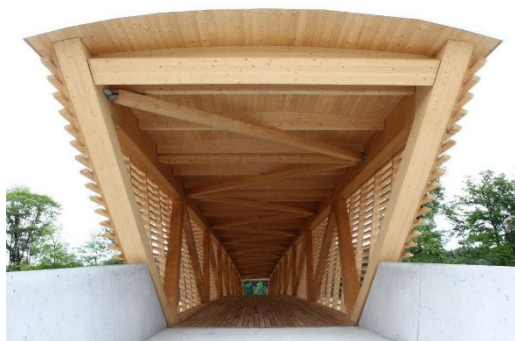
Abb. 1.8: Neumattbrücke in Burgdorf (BE). Fachwerkbrücke für den Langsam-Verkehr mit hochbeanspruchten Bauteilen aus Eschen-BSH, in der Skizze braun dargestellt. (Bilder: neue Holzbau AG).
