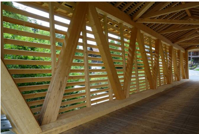
Abb. 1.4: Brücken-Hauptträger ausgebildet als BSH-Streben-Fachwerk (links), mit eingeklebten Gewindestangen in den Knoten (rechts). (Bilder: neue Holzbau AG)
