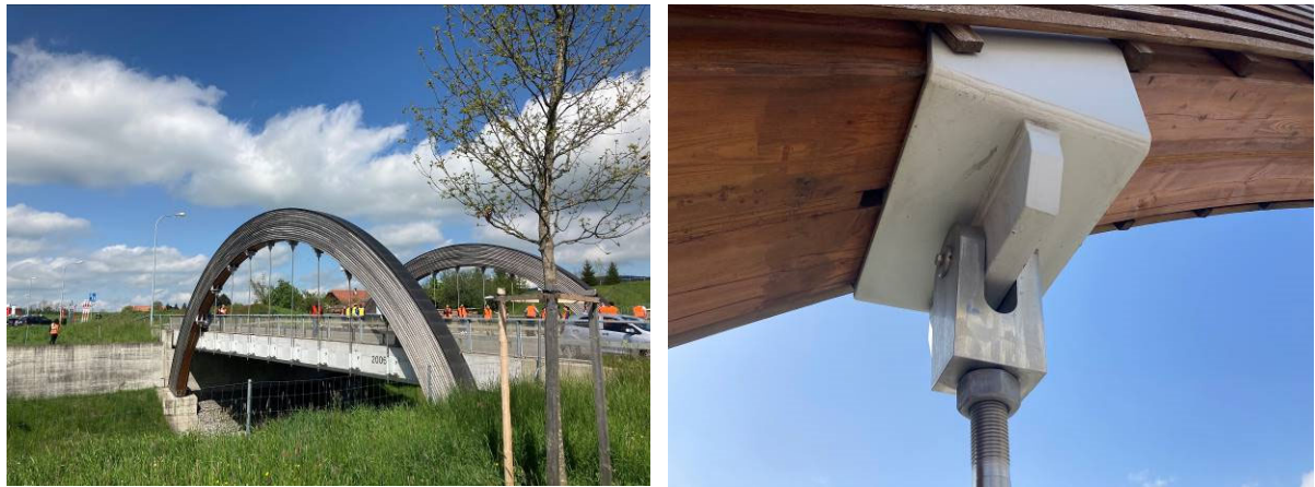
Abb. 1.6: Bogenbrücke Pont de la Pâla in Bulle (FR) mit Stahlhängern, welche mittels Stahlblechen und Bolzen am Bogen angeschlossen sind. (Fotos: Bruno Zumbrunn-Maurer).
