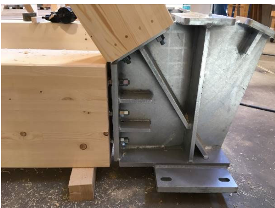
Abb. 1.5: Anschlüsse von Fachwerkstäben an ein Stahlteil im Bereich des Brücken-Auflagers. (Bilder: neue Holzbau AG)
