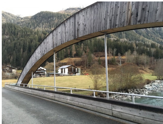
Abb. 1.7: Bogenbrücke in San Niclò (GR), bei welcher die Anschlüsse der Hänger an die Bögen mit eingeklebten Gewindestangen realisiert wurden. (Foto: Bruno Zumbrunn-Maurer, Planskizze: neue Holzbau AG).
