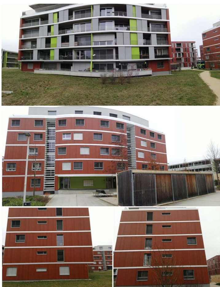
Figure 33 : Photographies des façades du bâtiment.
