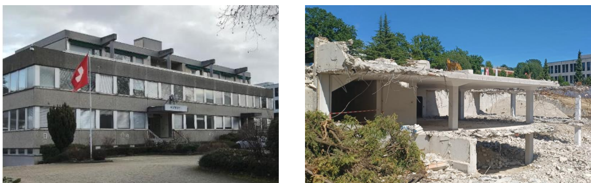
Figure 74: Photographies du bâtiment en cours de démolition avec une partie démolie et une autre préservée pour le réemploi des éléments en béton armé (photographie : Julien Pathé, 2401)
