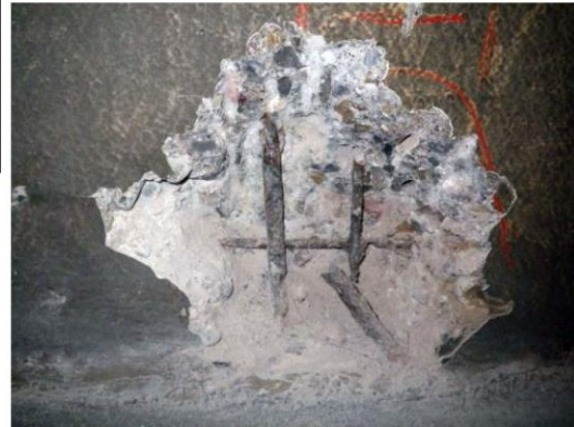
Abb. 10 Quelle links: SIA Merkblatt 2006: 2013; Anhang D, Quelle rechts: Sondieröffnung bewehrtes Innengewölbe Gubristunnel 2010 (SGK)
