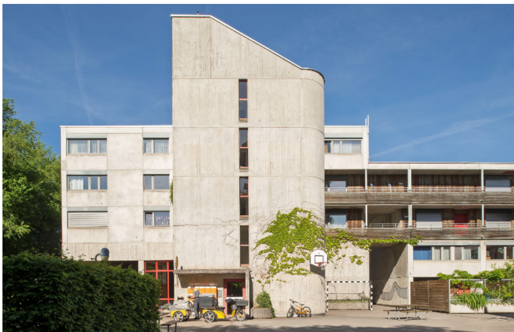
Abbildung 13: Siedlung Unteraffoltern III in Zürich, Quelle: Baugeschichtliches Archiv Zürich (BAZ), © Juliet Haller
