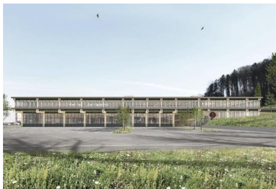
Abbildung 86: Aussenansicht, Wartebereich vor der Prüfbahn-Einfahrt
