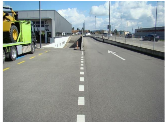
Abbildung 82: Ausfahrt Prüfbahnen und Prüframpe (links)
