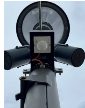
In Ringoldingen wurden DALI-Bewegungsmelder installiert. Die Einbindung der Bewegungsmelder erfolgt direkt auf den DALI-Bus (Prinzipschema Bild links). Auf dem Foto rechts ist der Bewegungsmelder zusammen mit Kabeln und einer Schutzhaube zu sehen, die für den Witterungsschutz sorgt. Das Bild rechts zeigt die Montage des Bewegungsmelders am Kandelaber. Da der DALI-Bewegungsmelder nicht für den Einsatz im nassen Außenbereich vorgesehen ist, wurde die Schutzhaube speziell für dieses Einsatzgebiet von der BLS angefertigt.
