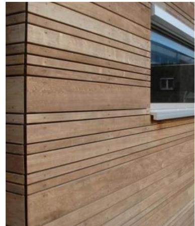
Abbildung 19: Fassade aus Thermoholz
