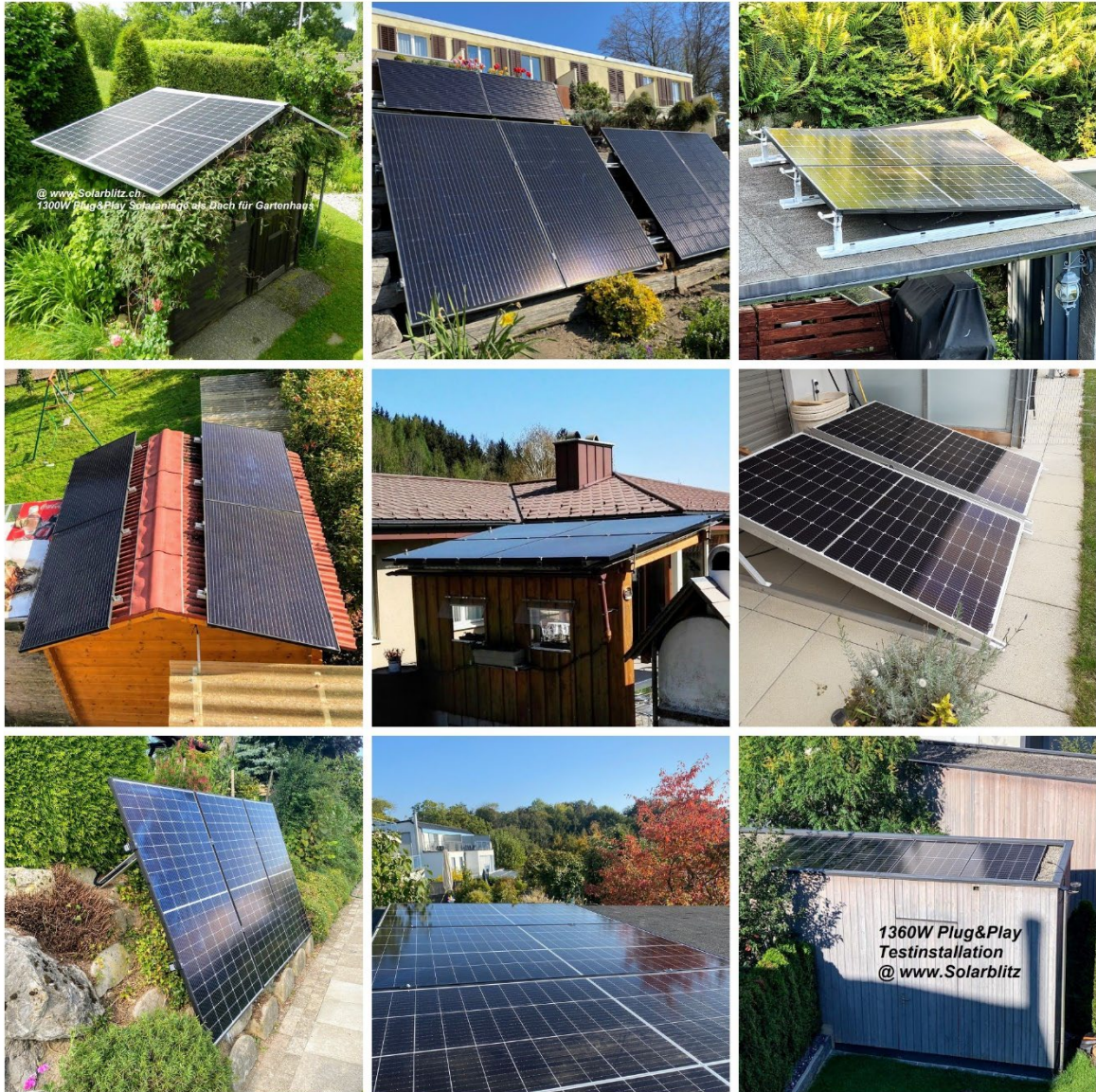
Abbildung 15 Beispiele für Nicht-Balkon-Plug & Play-PV-Systeme, deren Potenzial in der vorliegenden Potenzialstudie nicht berücksichtigt ist. Quelle: Solarblitz.ch
