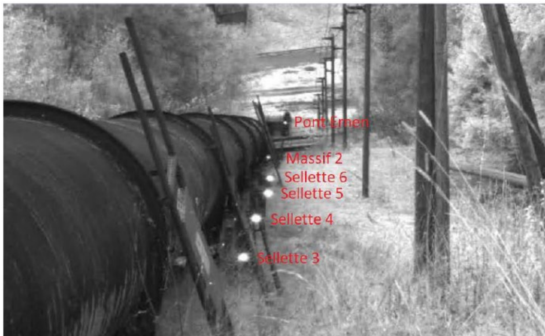
Figure 8 : Déploiement des cibles le long de la conduite forcée
