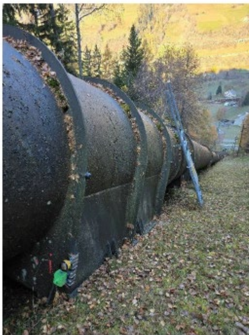
Figure 21 : Capteurs au massif 2
