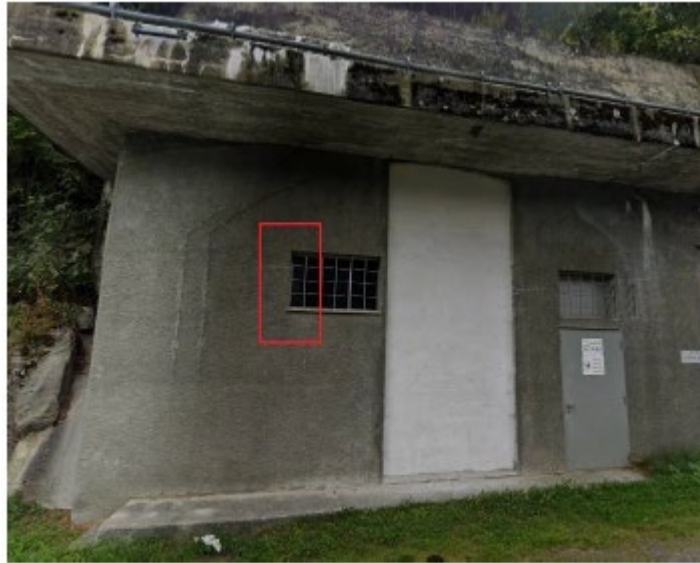
Figure 11 : Emplacement du gateway LoRaWAN au bâtiment de la vanne de tête
