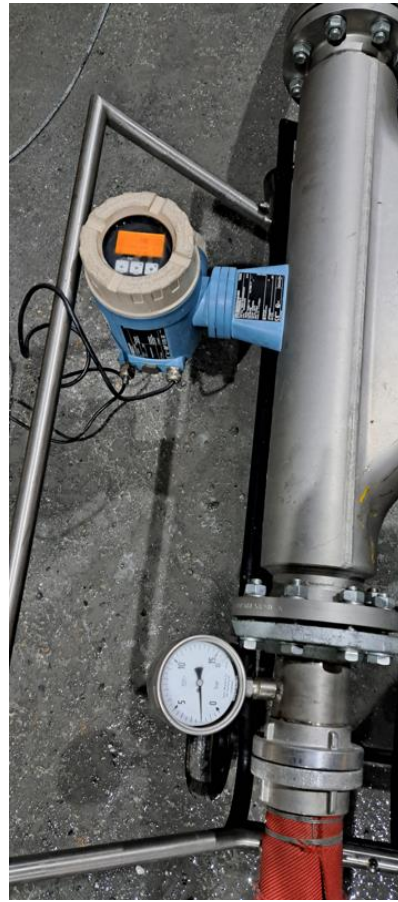
Abbildung 26: Druck- und Durchflussmessung
