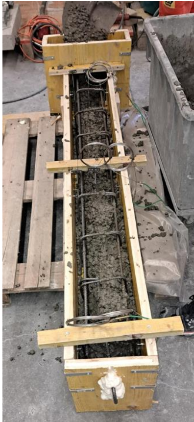
Abbildung 9: Betonierung der Stützen
