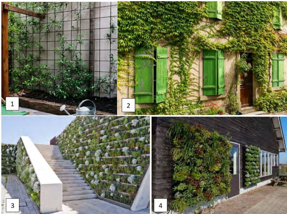
Figure 6: Différentes typologies de façades végétalisées. (1) Façade verte indirecte sur treillis ; (2) Façade verte directe avec lierre ; (3) Mur vivant continu ; (4) Mur vivant modulaire.
