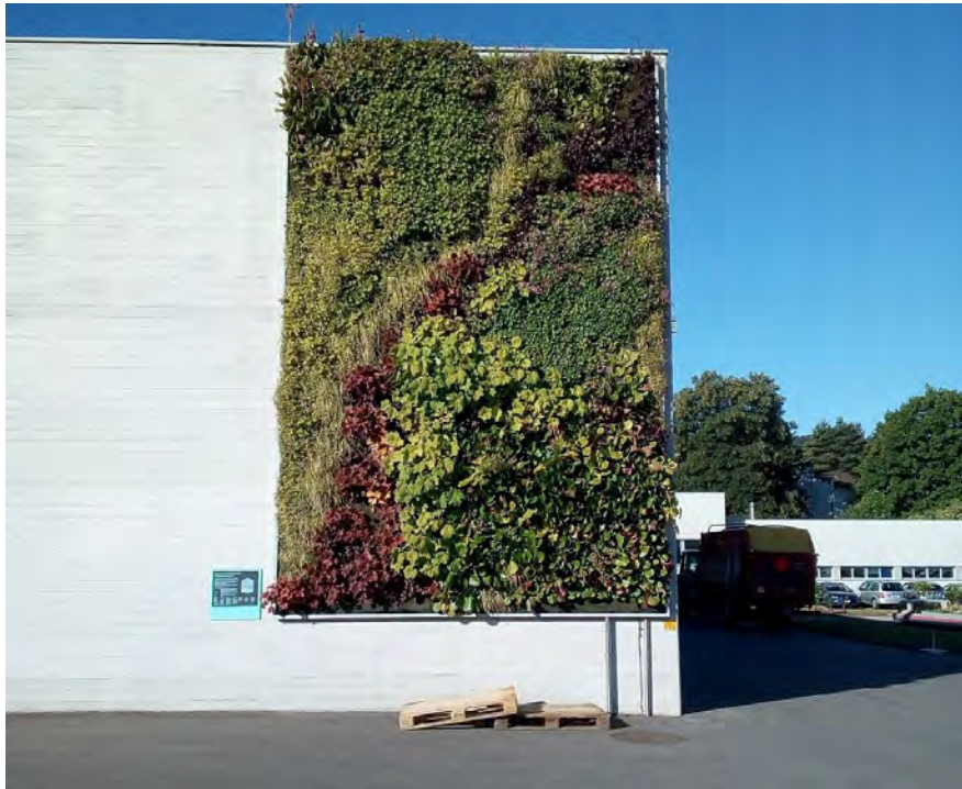
Abbildung 19: Versuchsobjekt für die Wärmebildaufnahmen. Zu sehen ist die nördliche Fassade an am Lagergebäude der Stadtgärtnerei Zürich. (Bild: Evelyn Trachsel)
