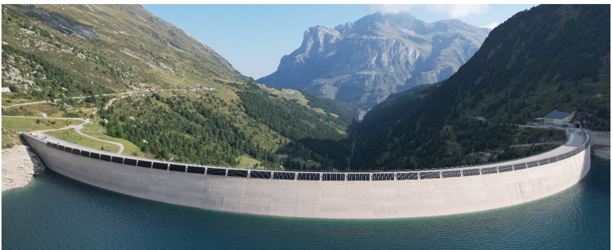
PVA-Anlage an der Lago di Lei Staumauer (Quelle: ©REECH AG, 2022)
