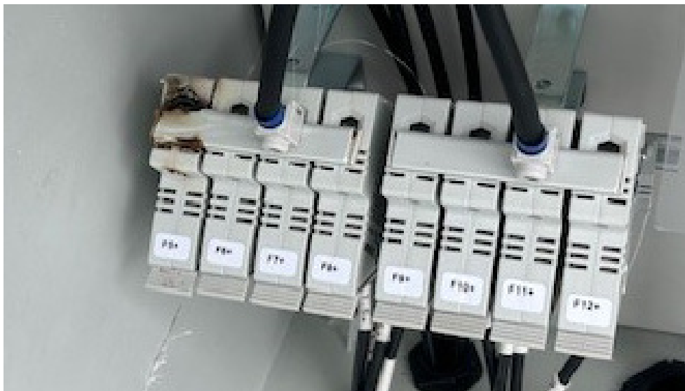
Abbildung 33 Durchgeschmorte Strangsicherung in GAK 1
