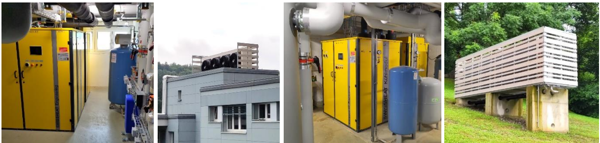
Abbildung 8: Wärmepumpen und Luftwärmetauscher der beiden Häuser K8 (links) und K6 (rechts)
