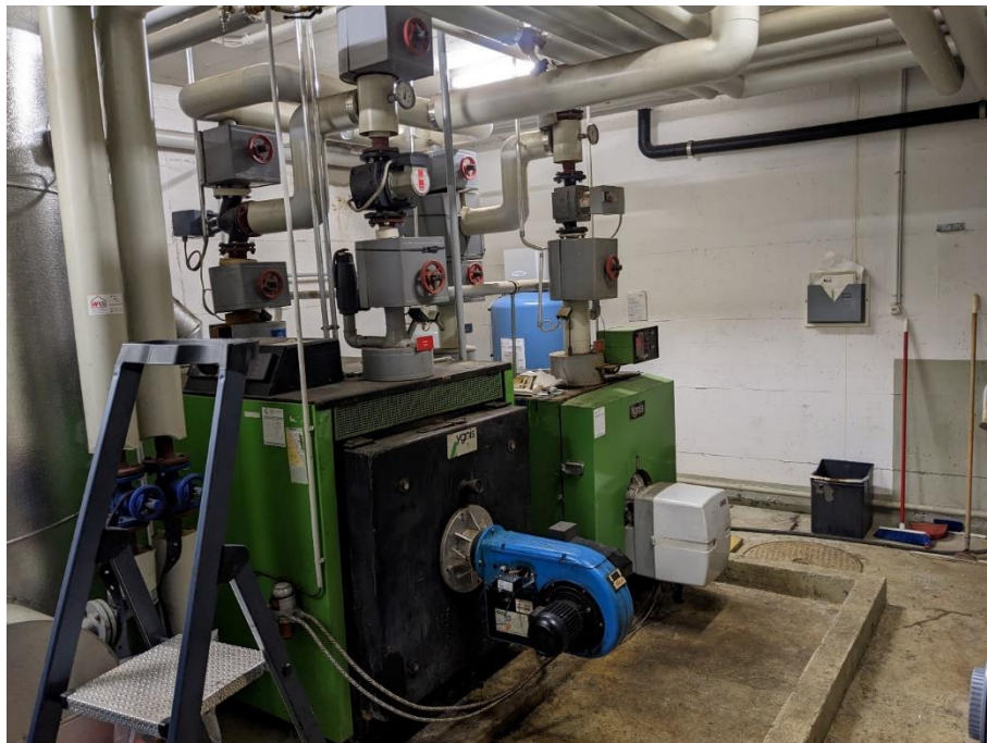
Abbildung 4: Alte Heizzentrale im Haus 6 mit den beiden Ölkesseln
