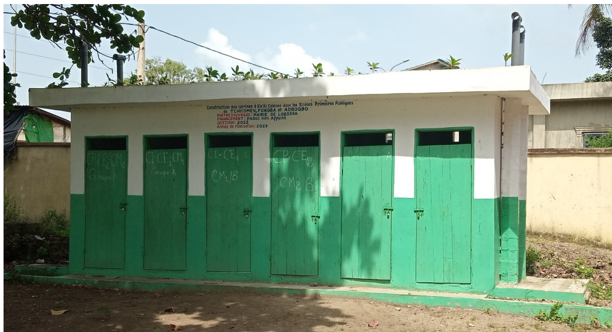
Photo 3: Module de 6 latrines réalisé en 2023 sur fonds FADeC 2022 réparties suivant les cours pour les apprenants et les groupes pour les enseignants.
