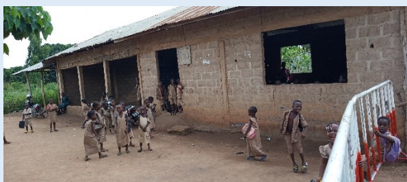
Photo 1 : 1er bâtiment construit par la population
