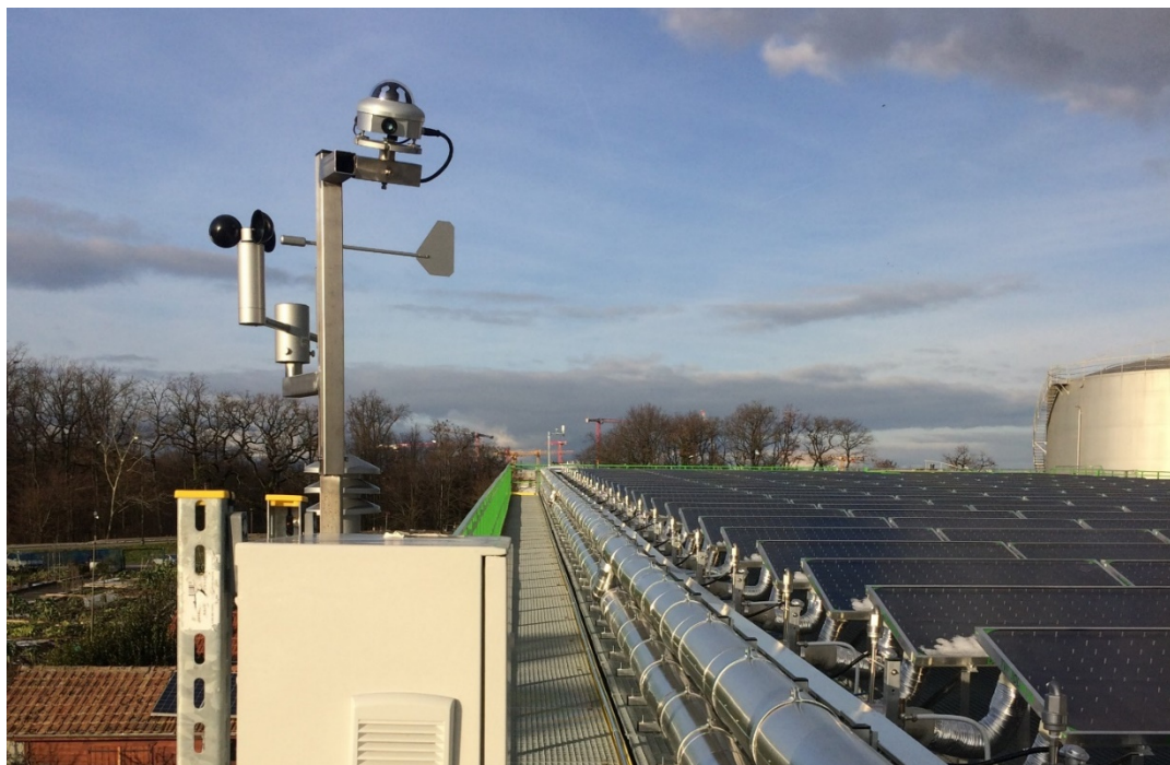
Figure 16 : La Station météo positionnée au centre du champ de capteur et à proximité de l'armoire d'acquisition déportée, installé au milieu du champ solaire.
