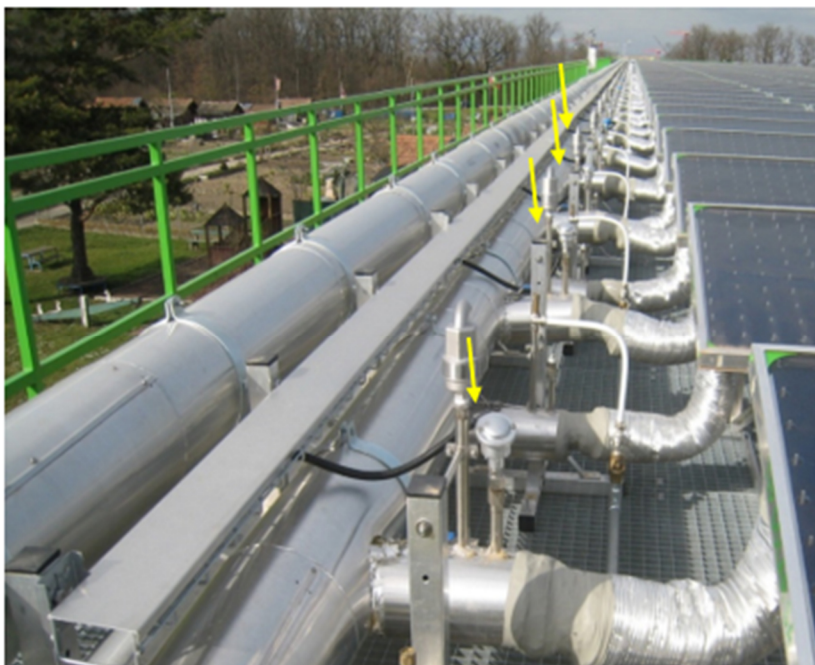
Figure 15 : Positionnement des sondes de températures sur le champ solaire
