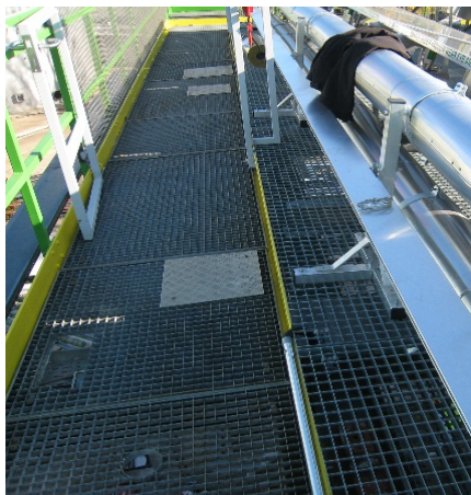
Figure 71 : Photos des différents aménagements structurelles de sécurité (caillebotis à gauche et barrière de sécurité à droite)
