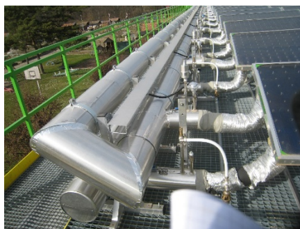
Figure 7 : Conduites hydrauliques du champ solaire (départ en bas, boucle de Tichelmann sur le retour en haut).
