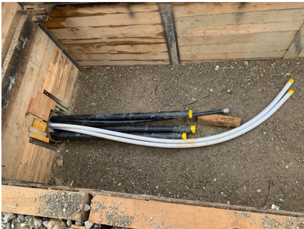
Figure 17 : Ensemble des tuyaux contenus dans le fourreau en acier selon la coupe présentée à la figure 3
