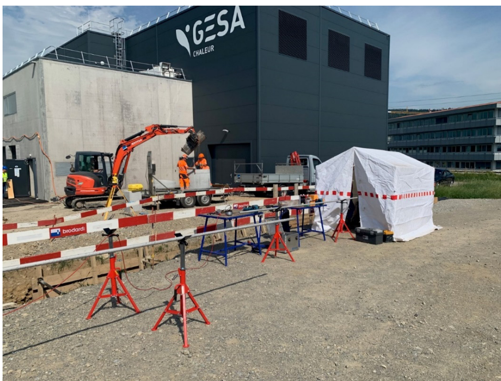
Figure 20 : Place de travail des soudeurs qui assemblent des tronçons de 6 m par 6 m
