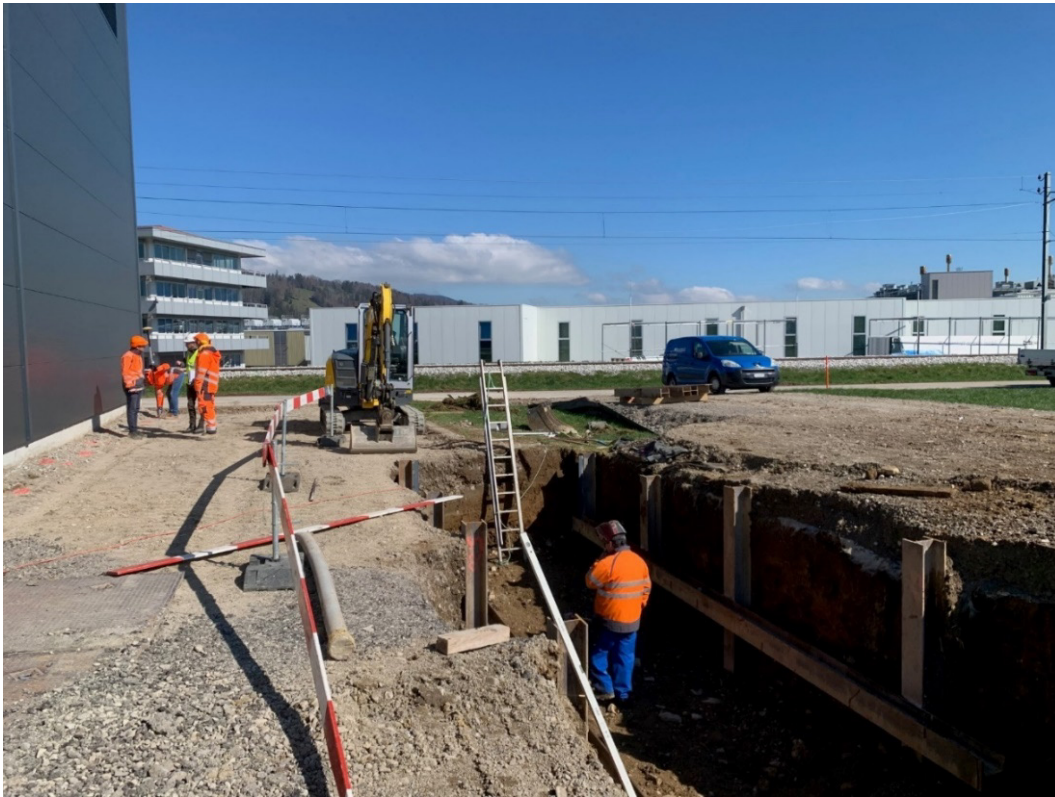
Figure 14 : Cellule de départ du côté GHP avec un coffrage en bois en raison de la longueur (20 m) et la profondeur (3 m) nécessaire pour l'introduction de la conduite hydrogène soudée de manière rectiligne
