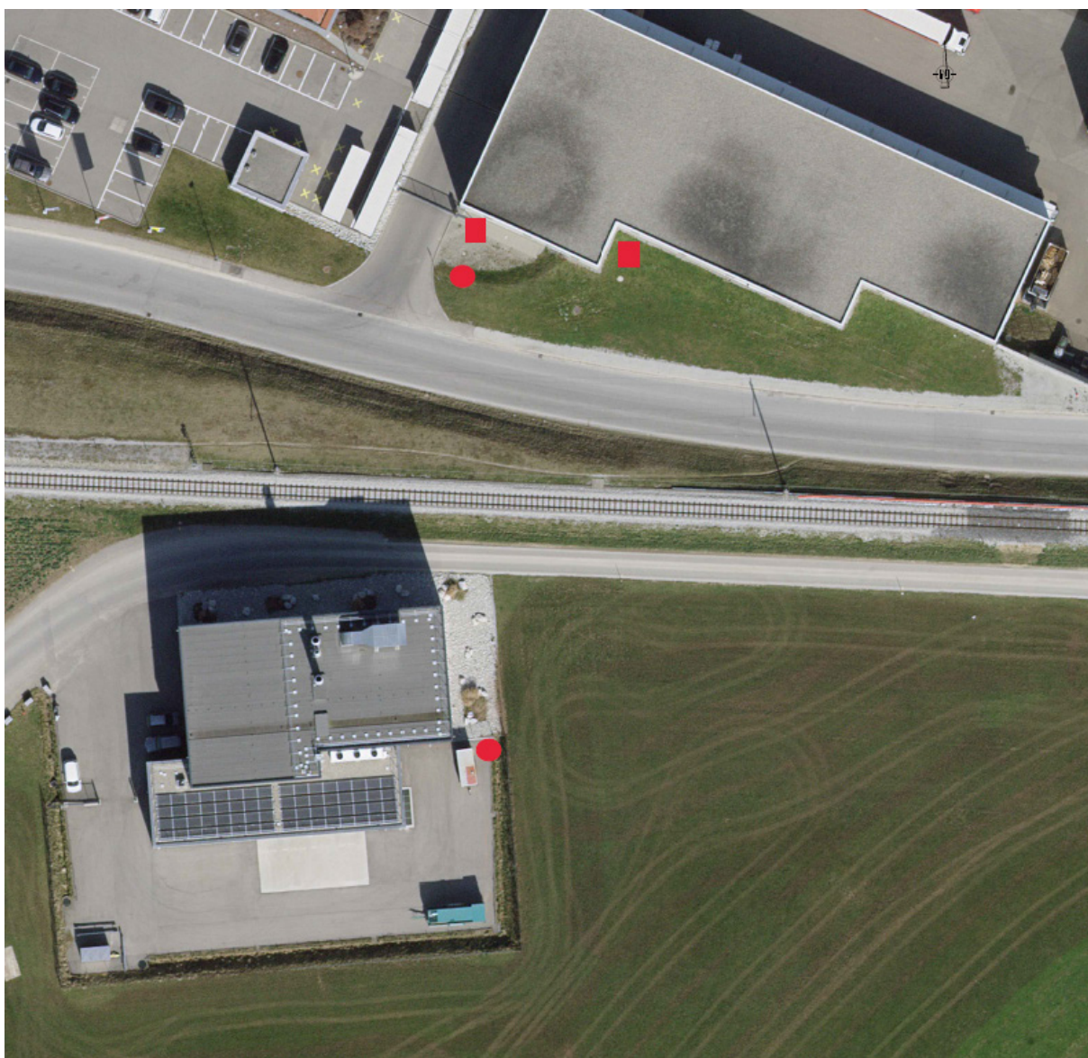
Figure 1 : Au-dessous de la voie de chemin de fer se trouve le site de GHP où a été construite l'installation de production d'hydrogène vert ; entre les deux ronds rouges a été construit le pipeline d'hydrogène en recourant à un forage. Au-dessus de la voie de chemin de fer se trouve l'interface avec le consommateur, l'entreprise Liebherr ; entre les deux carrés rouges a été construit le pipeline d'hydrogène en effectuant une fouille ouverte
