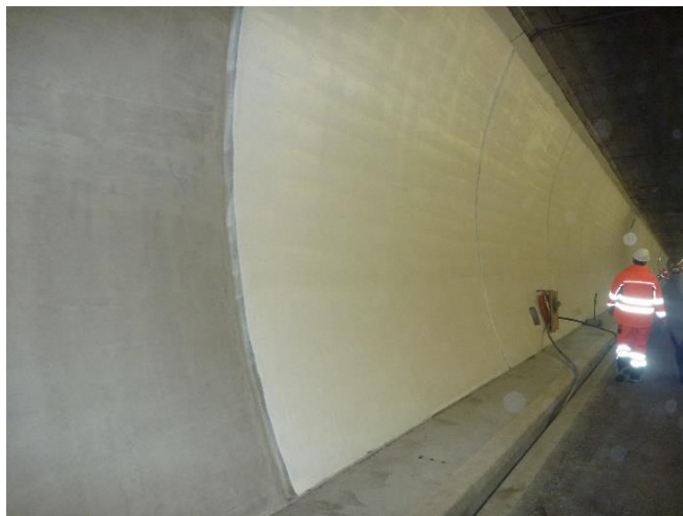
Abb. 11 Quelle: Cityring Luzern, Sonnenbergtunnel, Gewölbe (EBP Schweiz AG)
