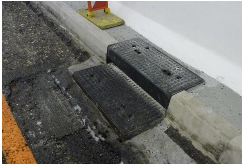
Abb. 28 Quelle: Cityring Luzern, Sonnenbergtunnel (EBP Schweiz AG)
