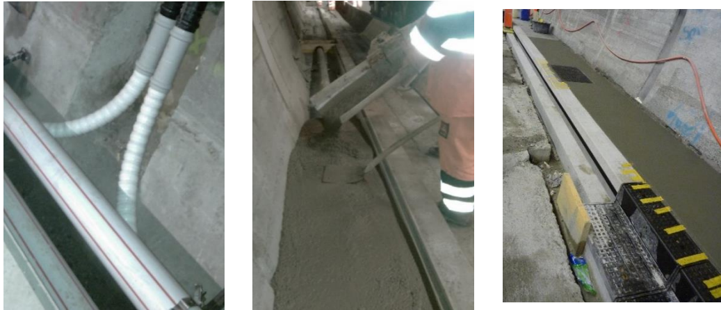
Abb. 22 Quelle: Cityring Luzern, Sonnenbergtunnel (EBP Schweiz AG)
