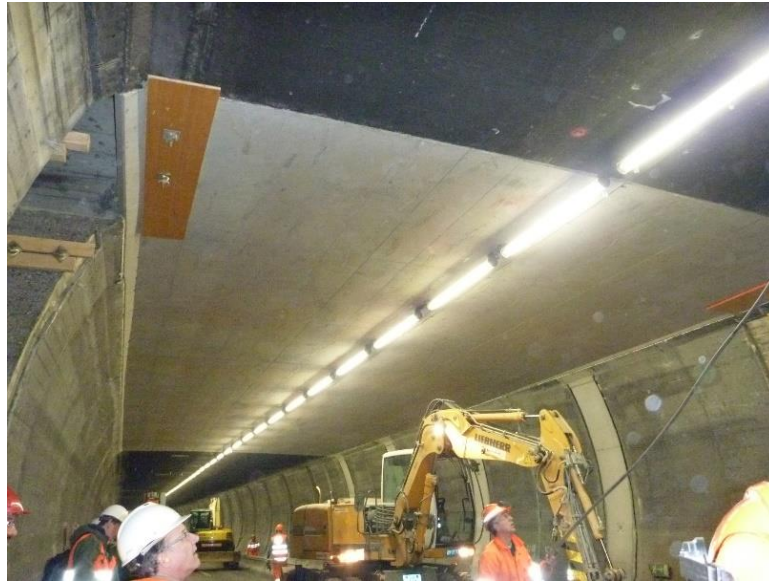
Abb. 20 Quelle: Cityring Luzern, Sonnenbergtunnel (EBP Schweiz AG)
