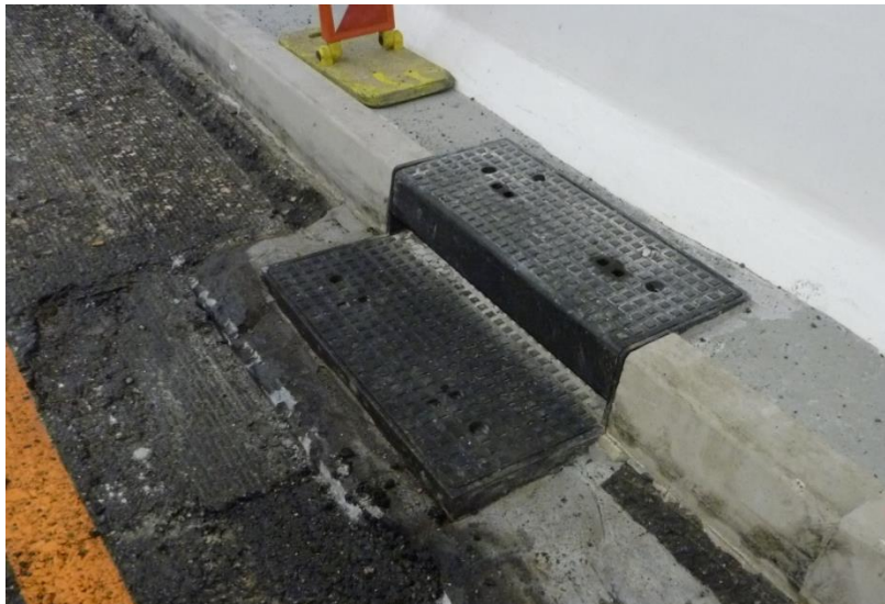
Abb. 27 Quelle: Cityring Luzern, Sonnenbergtunnel (EBP Schweiz AG)
