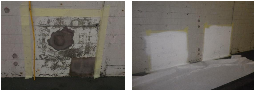
Abb. 10 Quelle: Gubristunnel, Gewölbe (EBP Schweiz AG)
