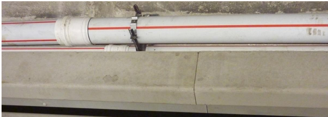
Abb. 25 Quelle: Cityring Luzern, Sonnenbergtunnel (EBP Schweiz AG)
