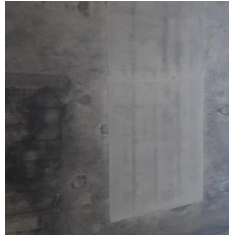
Abb. 2 Quelle: Gubristtunnel, Lokale Betoninstandsetzung, Gewölbe (EBP Schweiz AG)
