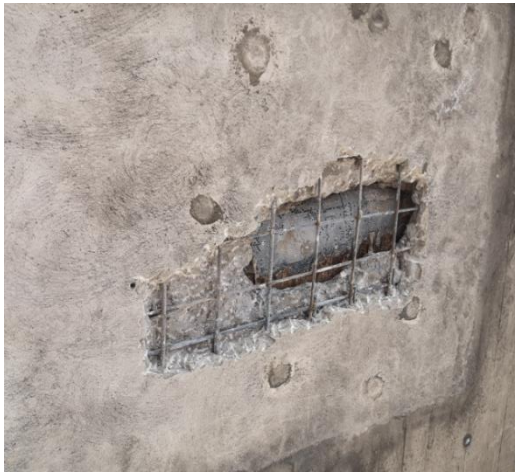
Abb. 2 Quelle: Gubristtunnel, Lokale Betoninstandsetzung, Gewölbe (EBP Schweiz AG)
