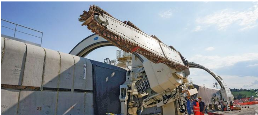
Abb. 2 Nazzano Methode: mechanisch unterstützter Vortrieb im Fels mit Felssäge [32]
