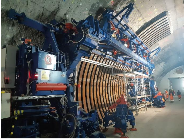
Abb. 4 Versetzroboter für Stahlbögen [28]
