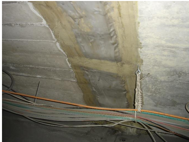
Abb. 16 Quelle: Cityring Luzern, Sonnenbergtunnel, Gewölbe (EBP Schweiz AG)
