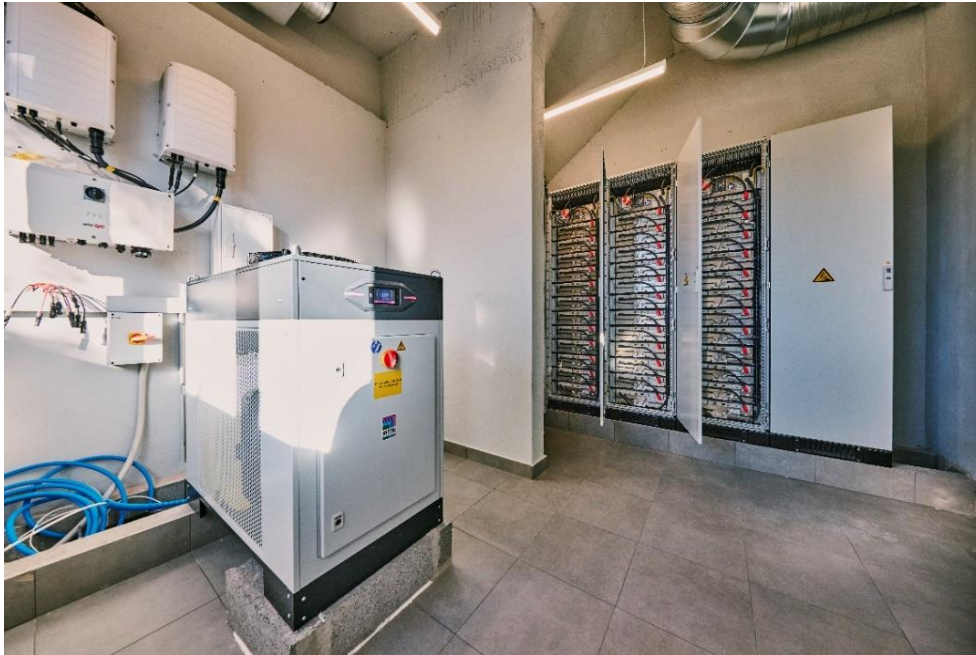
Abbildung : Kühlsystem im Vordergrund, Batterieschränke im Hintergrund
