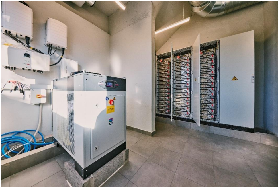
Figure : Système de refroidissement au 1er plan, armoires à batteries au 2 ème plan
