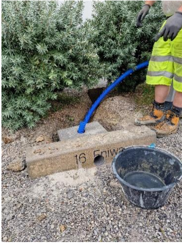
Abbildung 29: Installation des Leerrohrs beim ersten Ladestationsstandort
