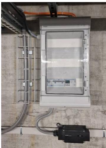
Abbildung 30: Box mit Monitoring- und Abrechnungssystem
