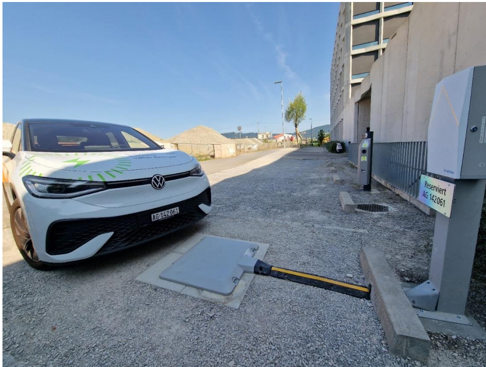
Abbildung 31: Fertiggestellte induktive Ladestation bei Eniwa in Buchs
