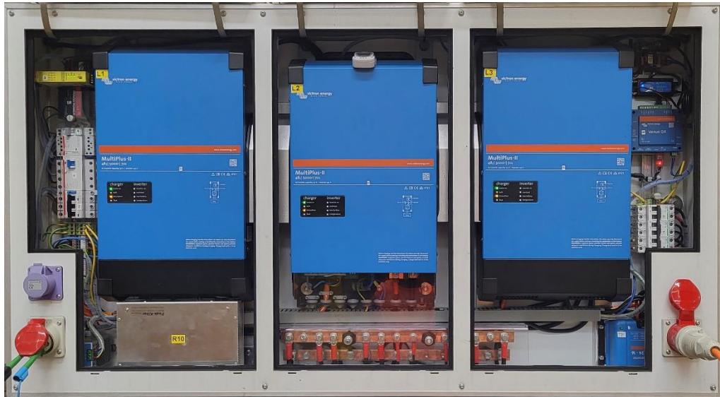
Abbildung 5: Aufnahme des Gehäuses der drei Victron-Wechselrichter des Typs 48/5000/70-50 sowie Verkabelung. Gehäusebau zum Zeitpunkt der Aufnahme noch nicht fertiggestellt.
