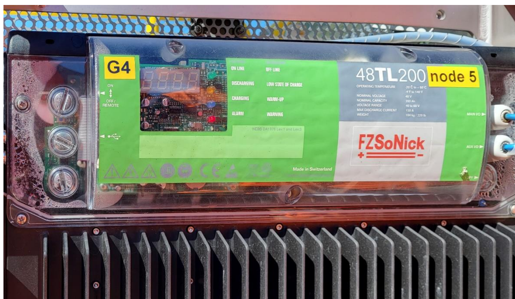
Abbildung 10: Kondenswasser an der Steuerungselektronik des Batteriemoduls 48TL200.
