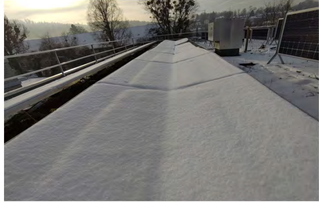
Abbildung 23: Die vertikalen Systeme (links) bleiben frei von Schnee, während die anderen Systeme erwartungsgemäss bedeckt sind und keinen Ertrag liefern.
