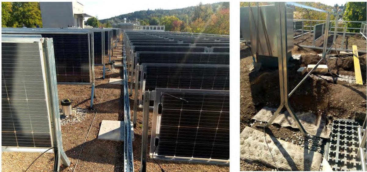
Abbildung 19: Die grossen bifazialen Module mit 72 Zellen haben sowohl einen umlaufenden Rahmen an jedem Modul wie auch einen zusätzlichen Rahmen der Unterkonstruktion (rechte Abbildung), der bei den grossen Modulen zu zusätzlicher Verschattung an der Oberseite führt. Bei den schmalen Modulen mit 48 Zellen fehlen diese Abschattungselemente an der Oberseite.
