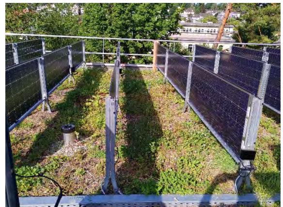
Abbildung 48: PV-System mit vertikalen Modulen. Die Fläche zwischen den Modulen kann begrünt werden und ist für Wartungsarbeiten zugänglich.
