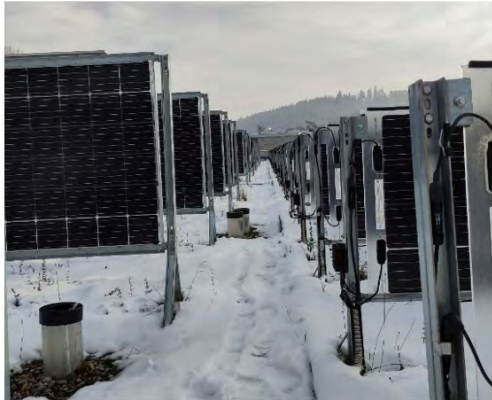
Abbildung 23: Die vertikalen Systeme (links) bleiben frei von Schnee, während die anderen Systeme erwartungsgemäss bedeckt sind und keinen Ertrag liefern.
