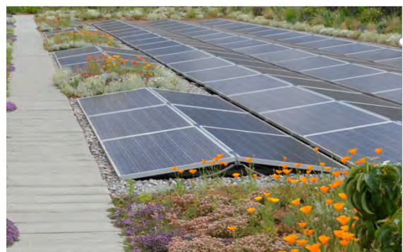
Abbildung 46: PV-System mit flachem Kippwinkel und teilweiser PV-Belegung der Dachfläche. Die verbleibende Fläche kann begrünt werden.
