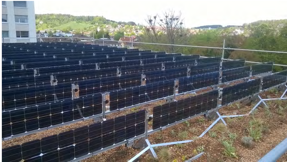
Abbildung 2: Vertikal montierte, bifaziale Lamine in Ost/West-Ausrichtung in schmaler, 20-zelliger Ausführung auf einem Gründach in Winterthur [4].
