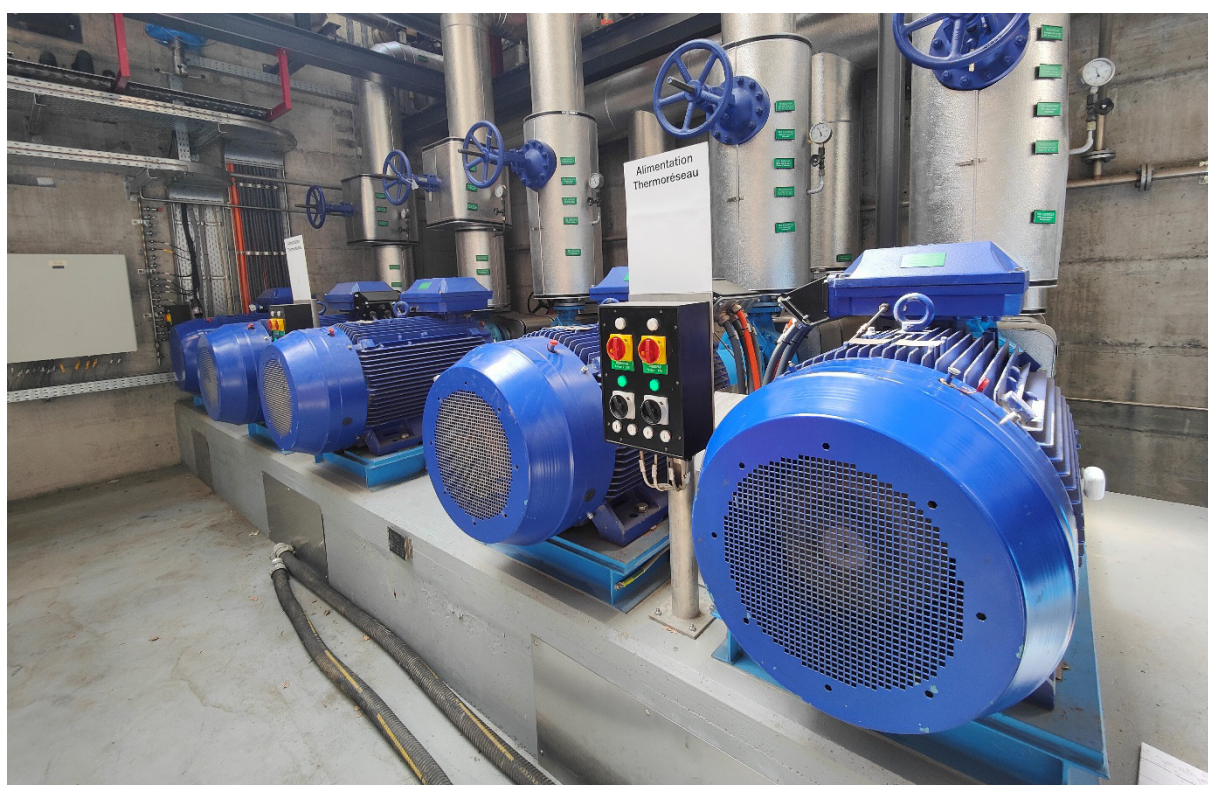
Figure 24 : Pompes actuelles pour la distribution du CAD
