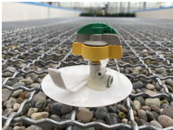
Abbildung 29: Aufbau und Installation der Düsen auf der Kiesschicht.
