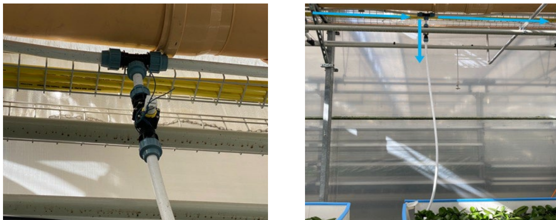
Abbildung 27: Wasserzuleitung über Magnetventile zu den Tischen.
