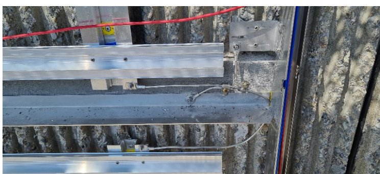
Abbildung 2: Rückseitige Montagekonstruktion mit geklebten PV-Modulen vorgefertigt auf Baustelle (links) – Potentialausgleich in der Montagekonstruktion (rechts)
