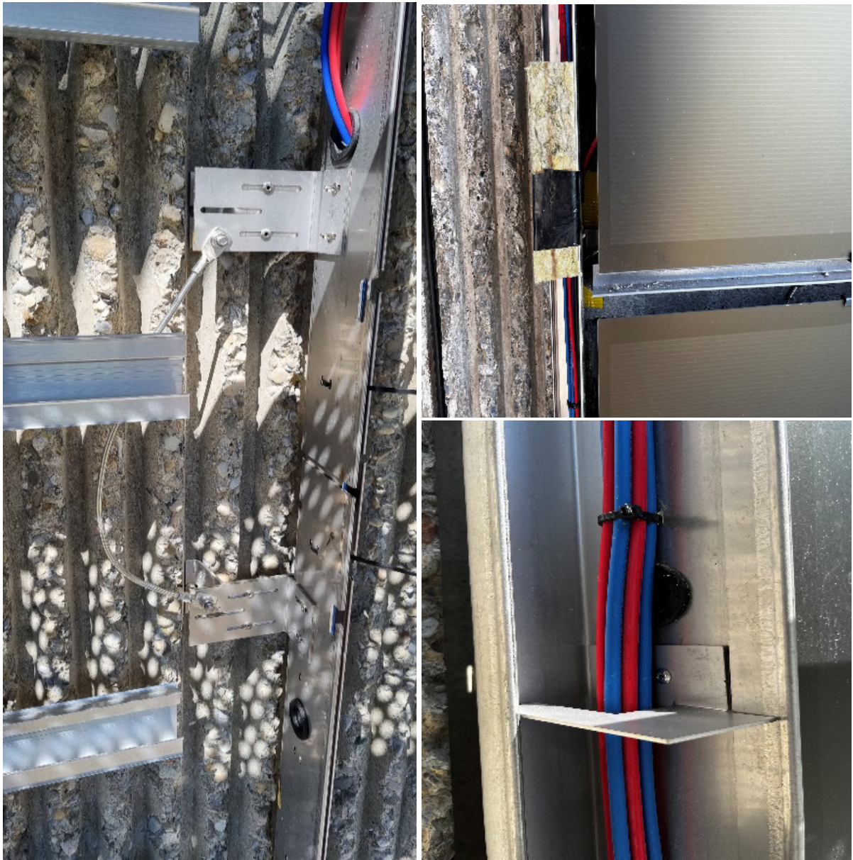
Abbildung 3: Abschottung des vertikalen Kabelkanals: Austritt aus dem Kanal (links) – Abschottung mit Isolationsmaterial im Kanal (rechts).
