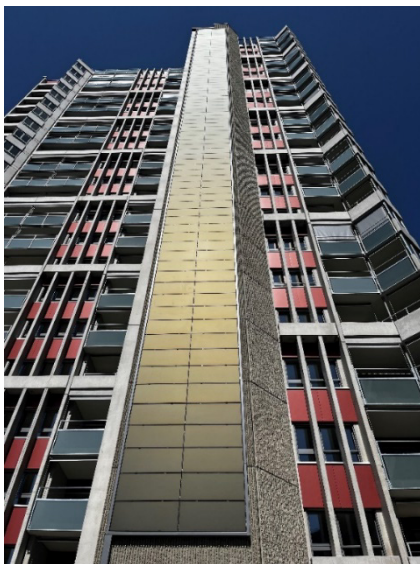
Abbildung 1: Eine der drei 70 m hohen PV-Fassaden des Gebäudes Holenacker 65 (links) – Kabel in Metallkanal mit Feldverteilkasten im Sockelbereich
