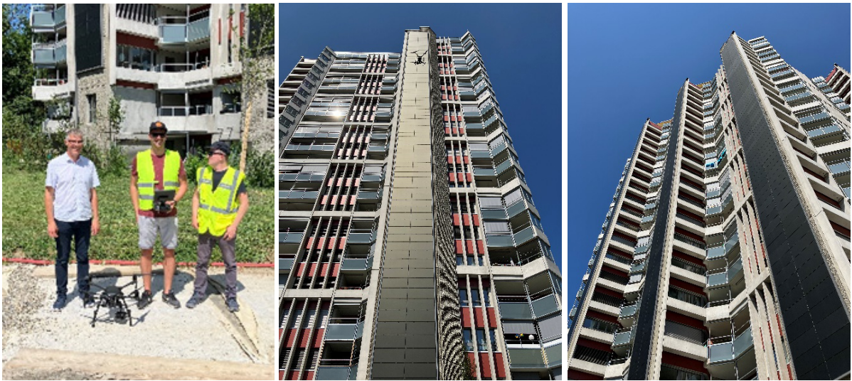
Abbildung 10: IR-Drohnencrew (vor Holenacker 65) – IR-Drohne vor der Fassade – die PV Fassade Holenacker 65 besteht aus mehreren PV-Streifen, diese werden einzeln abgeflogen, was sehr effizient ist.
