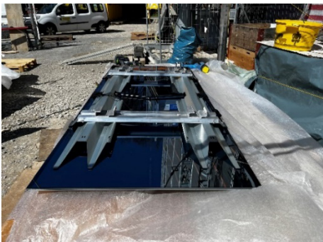
Abbildung 2: Rückseitige Montagekonstruktion mit geklebten PV-Modulen vorgefertigt auf Baustelle (links) – Potentialausgleich in der Montagekonstruktion (rechts)
