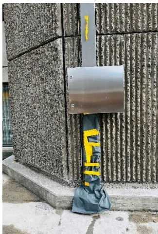
Bild: Eine der 4 PV Fassaden - GAK vor Gebäudeeintritt
