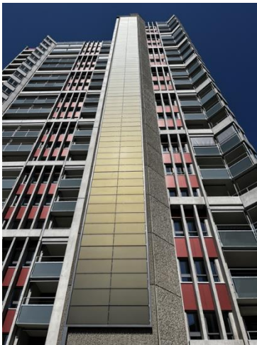
Bild: Eine der 4 PV Fassaden - GAK vor Gebäudeeintritt
