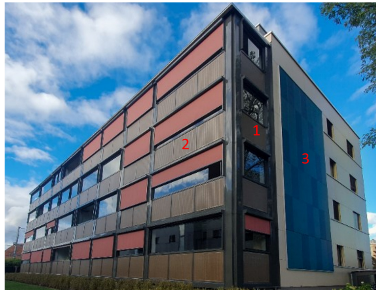
Abbildung 7: Gebäude 43 und 43a mit PV-Anlage Balkon Süd-Ost (1) und Süd-West (2) und auf Fassade Süd-Ost(3)
