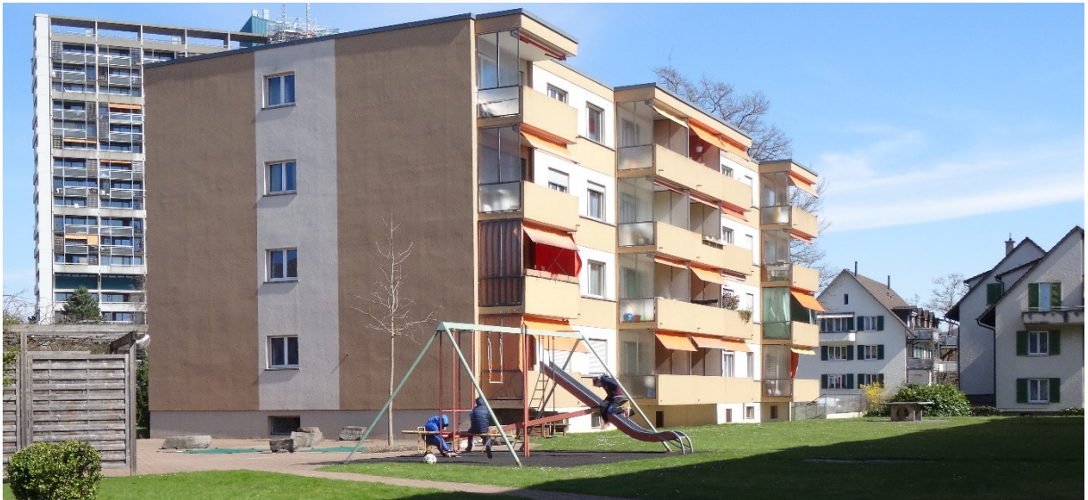
Abbildung 2: Brünnenstrasse 43a / 43 vor der Sanierung (Südwest-Fassade).
