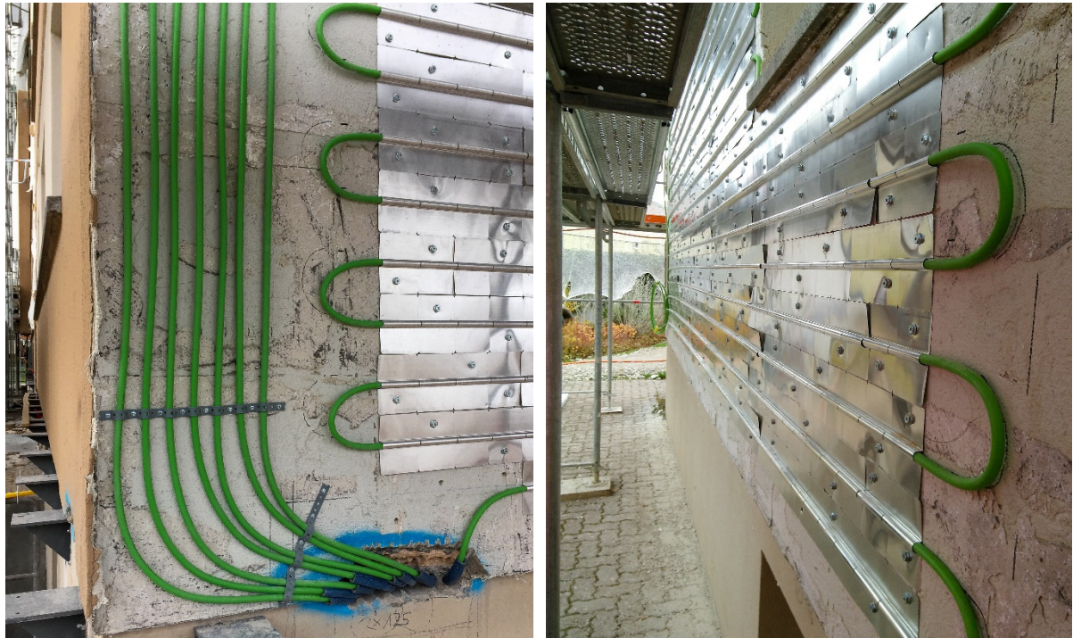
Abbildung 17: Installierte aussenliegende Wandheizung auf der Fassade, links: inkl. Wanddurchbruch mit Verteilungen, rechts: Heizmäander mit Wärmeleitblechen.
