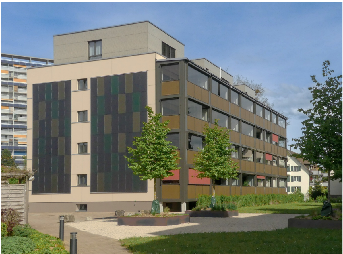
Abbildung 3: Brünnenstrasse 43a / 43 nach der Sanierung.
