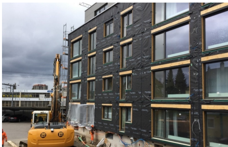
Abbildung 18: Die vorgefertigten Fassadenmodule müssen noch verkleidet werden.
