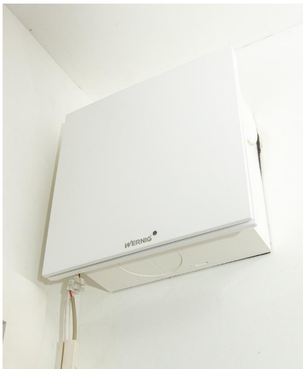
Abbildung 29 Aufputz montierter Abluftventilator der Testanlage (links); Schnittdarstellung des Abluftventilators von Wernig (rechts)
