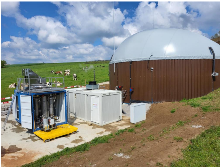
Abbildung 4: Biogasanlage am IAG mit dem Vorbehandlungscontainer (blauer Container) und dem BHKW der Biogasanlage (weisser Container).
