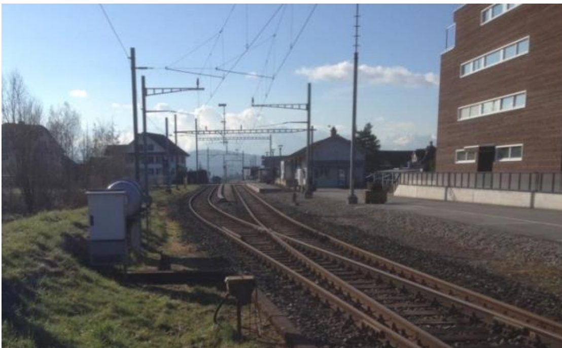
Abbildung 1: Bahnhof Eschenbach mit Propangasbehältern und alter Weichenheizung
