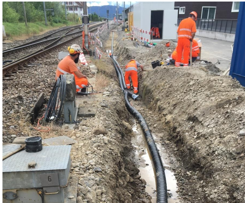
Abbildung 3: Verlegen der Nahwärmeleitung im Erdreich.
