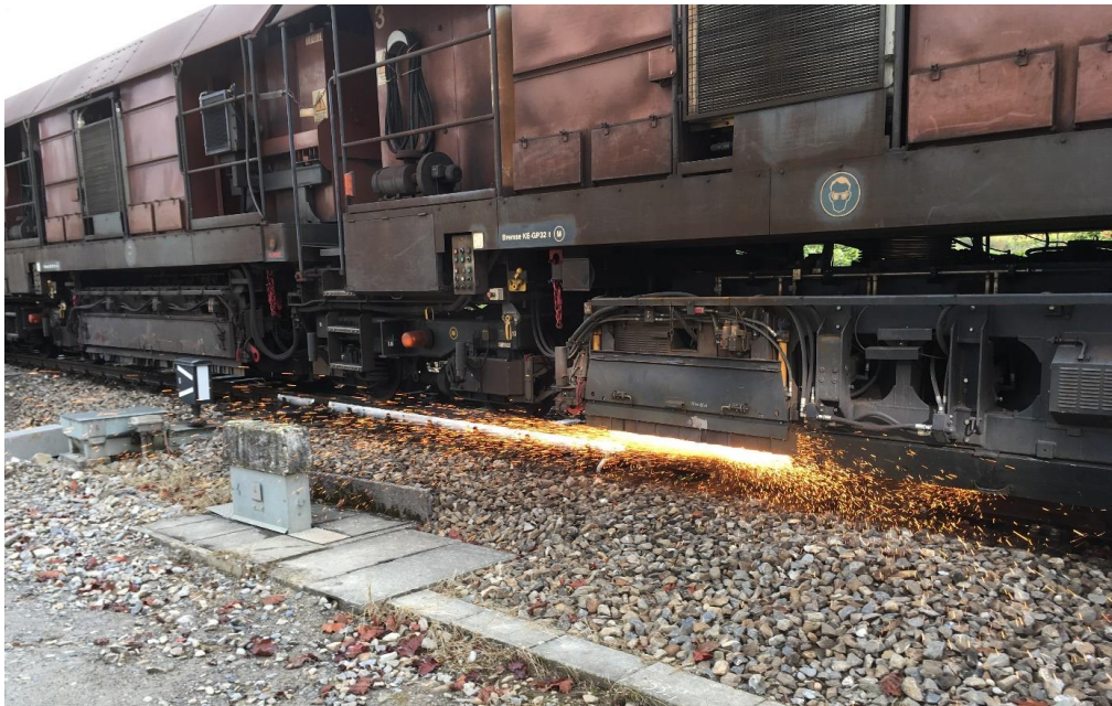
Abbildung 8: Schleifzug beim Schienenschleifen der Weiche 6 am 04. Oktober 2017.
