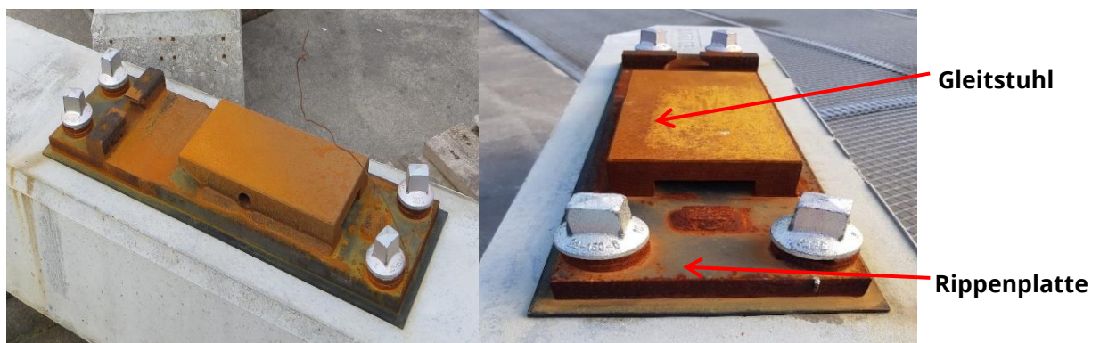
Bild 21: Rippenplatte mit Gleitstuhl auf einer Betonschwelle
