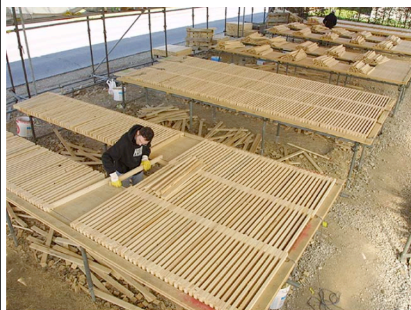
Abb. 3: Vorgefertigte Holzlatten werden in drei versetzt nebeneinander liegenden Reihen zu einem Rost zusammengesetzt.
