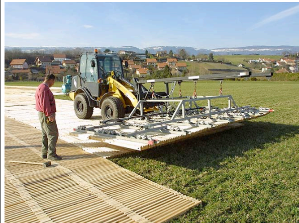
Abb. 5: Der Einbau vor Ort erfolgt mit leichten Maschinen.
