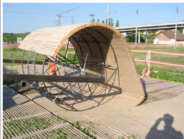
Abb. 6: Beim Rückbau werden die Elemente auf eine Walze aufgerollt.
