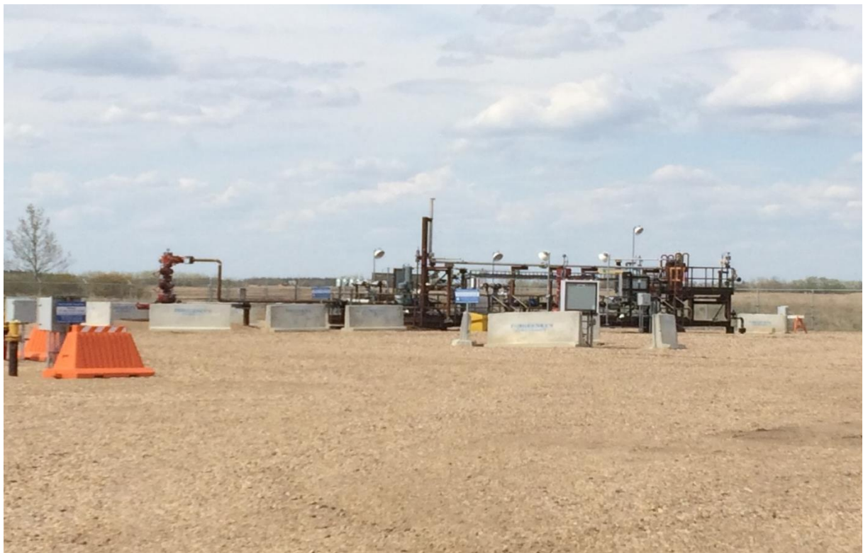
Abbildung 1: CO 2 Injektion am Quest Carbon Capture and Storage Projekt in der Region Edmonton, Provinz Alberta/Kanada. Mittels 3 Injektionsbohrungen wird seit 2015 rund 1 Mio. Tonnen CO 2 jährlich und bis Ende 2023 rund 9 Mio. Tonnen CO 2 in einer Tiefe von 2'000 – 2'500 m dauerhaft gespeichert. Die derzeitige Konzession erlaubt die Injektion von 27 Mio. Tonnen CO 2 . Wie nach der Standortsuche erwartet, gibt es bis heute keine Hinweise auf Leckagen oder erhebliche Unregelmässigkeiten. Die CO 2 Fahne verhält sich konform mit den jährlichen Prognosen. ( Bildquelle: Gunter Siddiqi, 2017; Textquelle: Quest 2022 annual status report - Alberta Energy Regulator und Carbon capture and storage - Shell Sustainability Report 2023 ).
