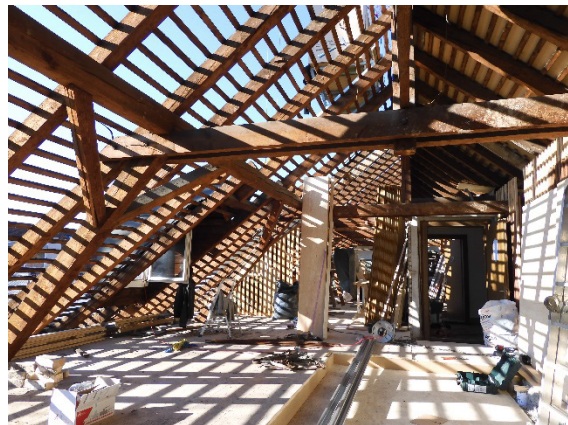
Abbildung 7: Betonfundamente für WP-Aufstellung (links) und Dach nach Abbruch der Kamine und Entfernung der Ziegel (rechts).
