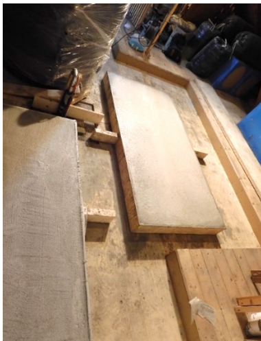
Abbildung 7: Betonfundamente für WP-Aufstellung (links) und Dach nach Abbruch der Kamine und Entfernung der Ziegel (rechts).
