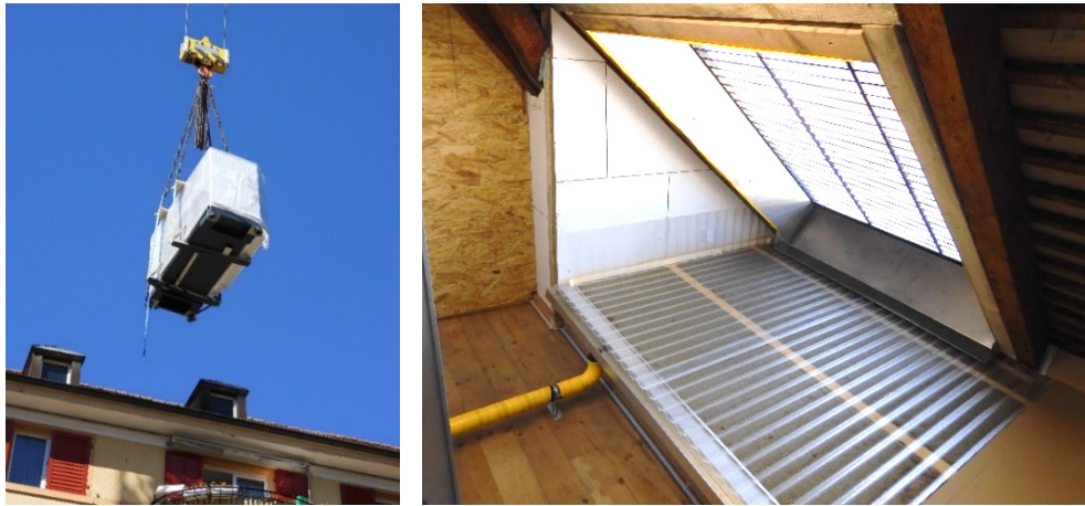
Abbildung 8: Einbringung einer Wärmepumpe (links) und Luft-Ausblasnische beider Wärmepumpen.
