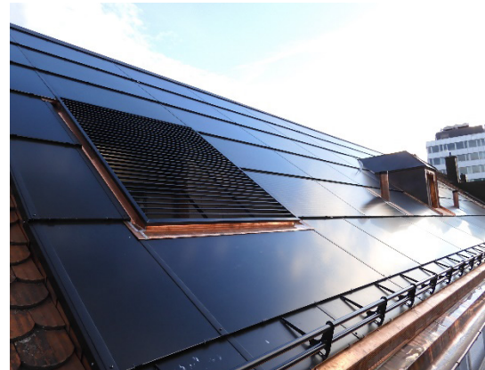
Abbildung 1: Südost-Fassade des Wohnhauses in der Denzlerstrasse, Zürich (links). Wärmepumpen-Ausblasgitter im Nordwest-Solardach (rechts).
