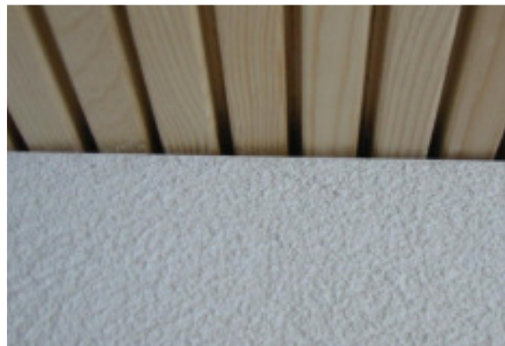
Detail A,B,C: Putzanschluss an Sichtdecke mit Trim-L Profil
