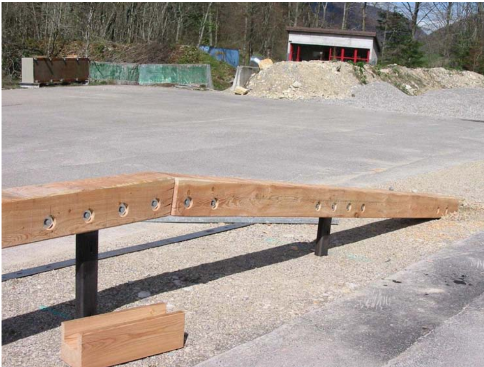
Absenkung und Verankerung der Leitschranke
